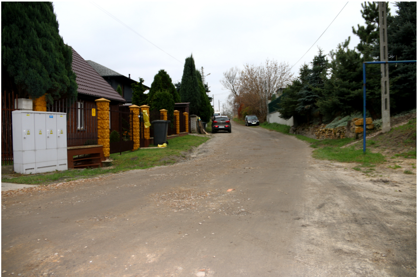
Ulica Zacisze przed inwestycją.
