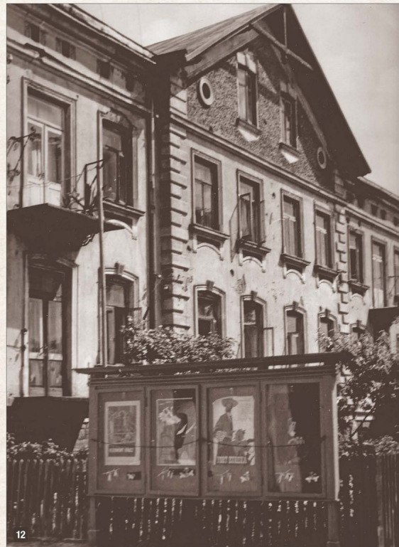
12 Kamienica czynszowa Giepardów przy ulicy Kolejowej 17. Był to najbardziej reprezentacyjny gmach w dawnym Wierzbniku, wyróżniający się wielkością i ozdobną elewacją fasady. W latach I wojny światowej mieściła się tu siedziba okupacyjnych władz austro-węgierskich. Na pierwszym planie znajduje się gablota z plakatami filmowymi kina, które znajdowało się na lewo od kamienicy; fotografia z połowy lat 50. XX w.
