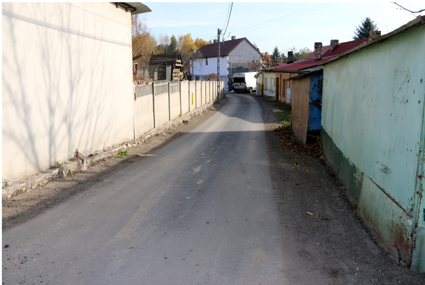
Ulica Owocowa z nową, asfaltową nawierzchnią.
