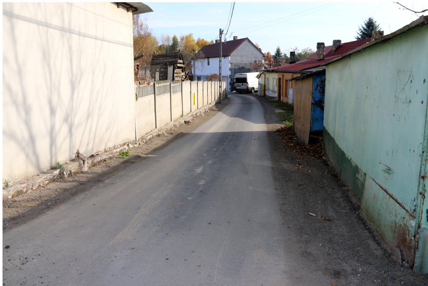
Ulica Owocowa z nową, asfaltową nawierzchnią.
